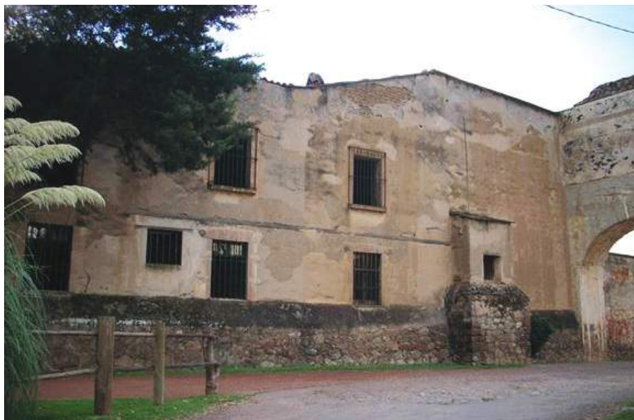
Parte da fachada externa.
