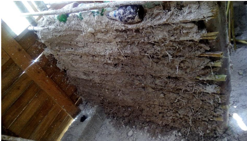
Construcción de paredes de una cabaña ecológica. Fuente: Acervo personal
