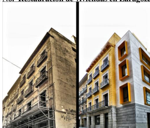
Imagen No. Restauración de viviendas en Zaragoza, España
