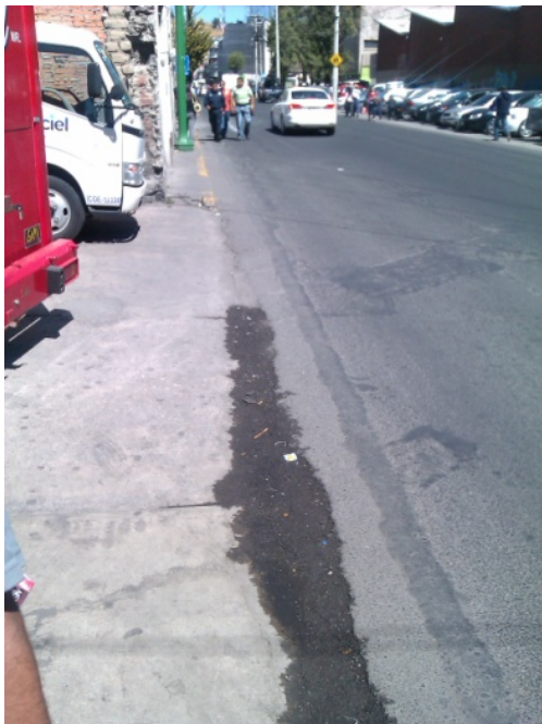
Calle de Rayón, zona de banqueta con un ancho insuficiente, se puede observar como un poste ocupa la totalidad de la acera.
