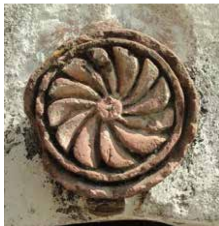
Ilustración 5: Detalle ubicado en la parte superior de un humilladero. Fotografía: Isabel Téllez.
