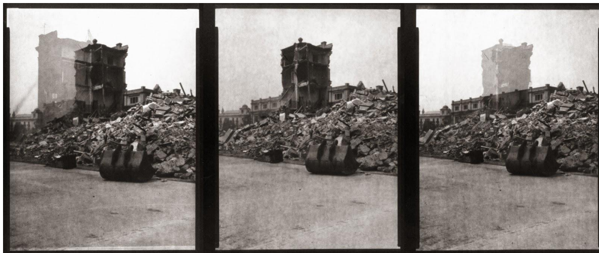
Imagen 9. M. Llorens Derribo de un edificio ferroviario en la Avd. Icària . 1989.
