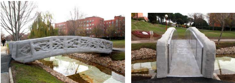
Figura 45 y 46: Puente impresión 3D en el parque Catilla- La mancha en Alcobendas, Madrid. (Alcobendas, 2016)
