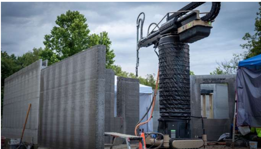
Figura 42: Impresora 3D de concreto. Fuente: (Apiscor, 2024)
