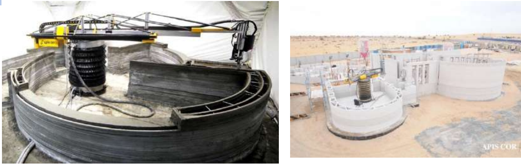
Figura 44: Impresora 3D de concreto. Fuente: (Apiscor, 2024)
