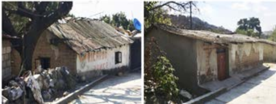
Figuras 2 y 3. Casas tradicionales construidas con ladrillos de arcilla (adobes). Santa María la Asunción, Zumpahuacán, México
