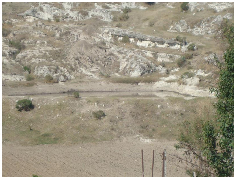
Figura 4.11. Bordos utilizados para almacenar agua de los escurrimientos
