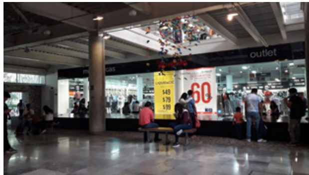
Estructuras de locales comerciales dentro del centro comercial San Francisco. Fuente: Foto JECL, 2019.
